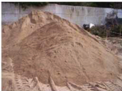
Acopio de Arena
